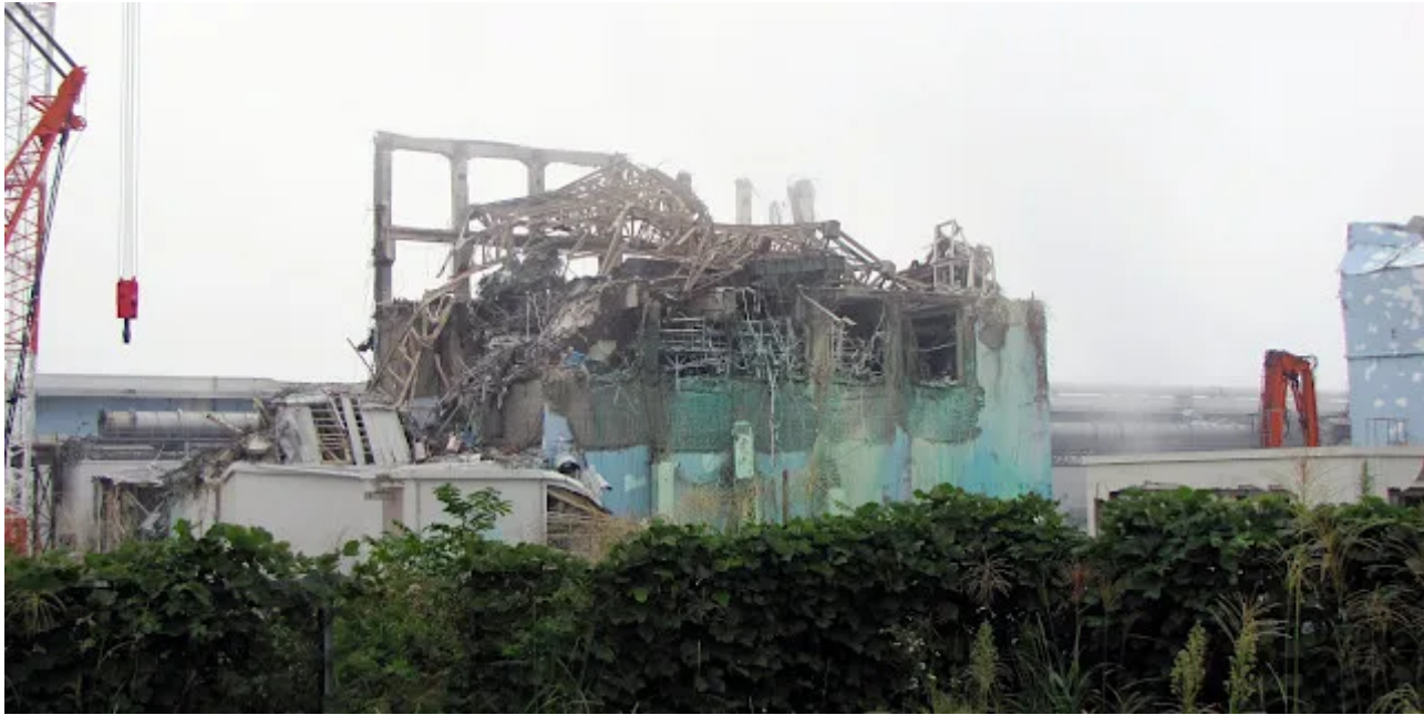
Fukushima Daiichi, zerstörter Reaktorblock Nr. 3, September 2011 | Bild: picture alliance / dpa / Tepco
